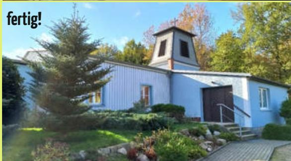
So wurden die Holzfassade und die Fenster gestrichen, der Sockel unterhalb der Holzfassade isoliert und neu verputzt, an der Putzfassade Schäden beseitigt und der Putz gestrichen. An der Turmhaube erfolgten die Reinigung der Kunstschiefer und eine Farbversiegelung. Auch das Turmkreuz erhielt einen Farbanstrich sowie einen Blechschutz. Die Außen- und ein großer Teil der Innentüren sind gestrichen.
